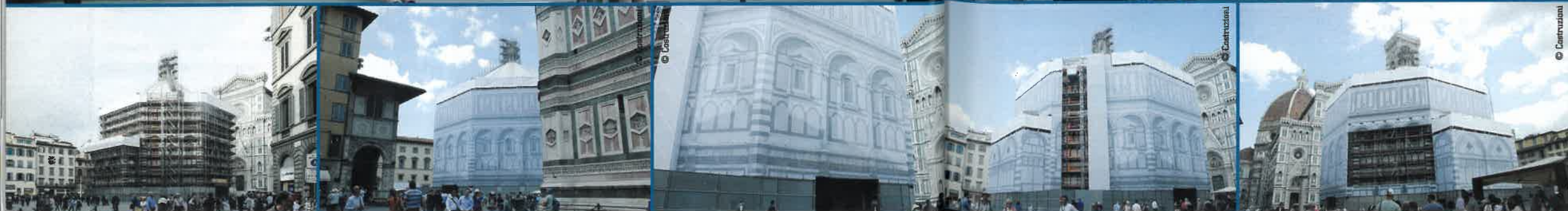
Il battistero di San Giovanni, a Firenze, durante i lavori di restauro delle facciate esterne, "vestito" col ponteggio Allround Layher.
