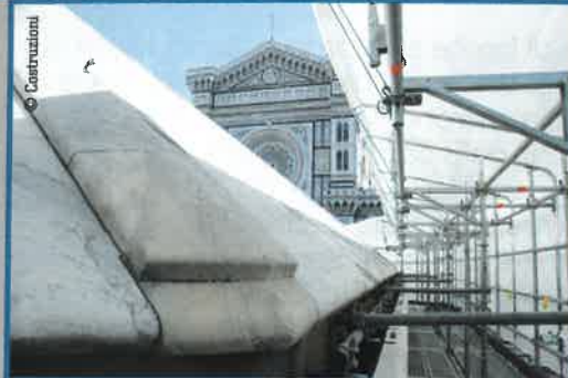
Alcuni dettagli della struttura Layher. Si notino, in particolare, il sistema di accesso alla lanterna realizzato con componenti Allround (seconda foto da sinistra) e il sistema di copertura con binari Keder e teli in PVC (prima e quinta foto).
